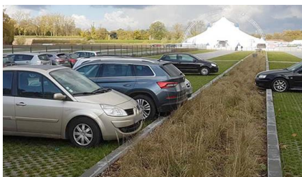
Parking 500 places de stationnement conçues en revêtement perméable extérieur engazonné - Lille
